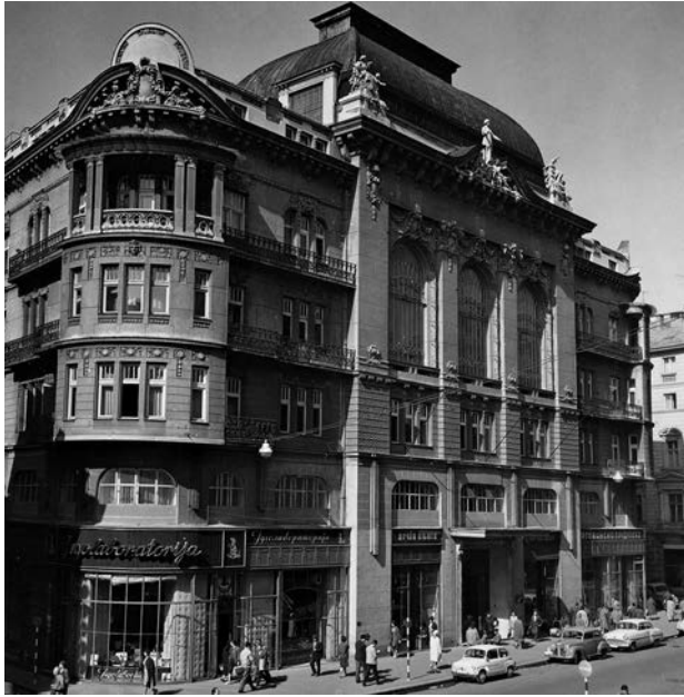
Зграда САНУ после реконструкције (Музеј града Београда)
